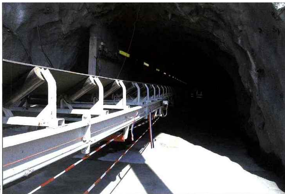
Posé sur une dalle bétonnée, le convoyeur traverse le tunnel dont la voûte est également bétonnée
